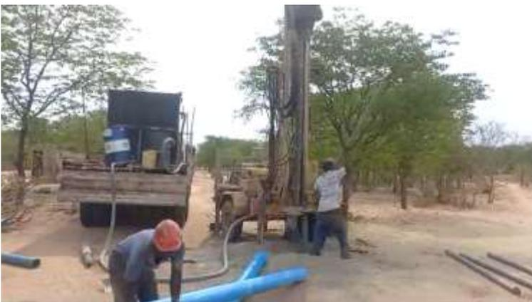
Der nach der Bohrung ausgeführte Kapazitätstest ergab, dass ein Bohrloch durch die ständig nachrutschenden Sedimentschichten „trocken“, also nicht nutzbar ist, aber das zweite so viel Wasser führt, dass die andere Siedlung mit Grundschule mitversorgt werden kann.
