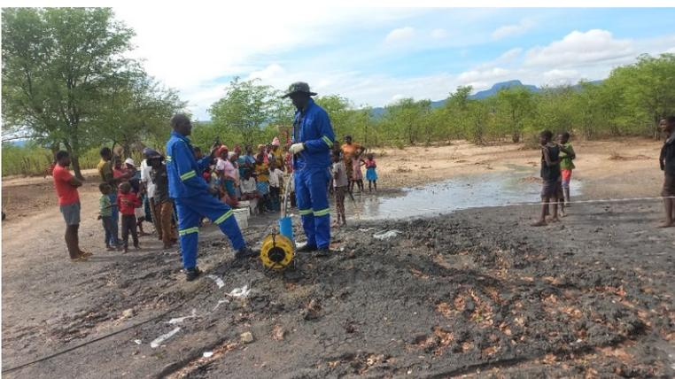
Am „starken“ Bohrloch wurde eine größere Pumpe installiert, mit der beide Siedlungen und die Grundschule durch erweiterte Leitungen und Tanks mit Wasser versorgt werden können. Beim Ausheben der Gräben für die Leitungen halfen alle mit. Bei der anschließenden Versammlung wurden die Anwohner eingewiesen und gleich wurden die ersten Behälter gefüllt. Als letzte Folgearbeiten wurden die Anlagen zum Schutz vor Schäden und für die Gewährleistung betoniert und eingezäunt.
