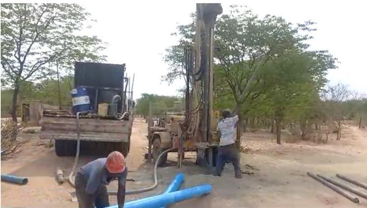
Der nach der Bohrung ausgeführte Kapazitätstest ergab, dass ein Bohrloch durch die ständig nachrutschenden Sedimentschichten „trocken“, also nicht nutzbar ist. Das zweite Bohrloch führt aber so viel Wasser, dass die andere Siedlung und deren Grundschule mitversorgt werden kann.
